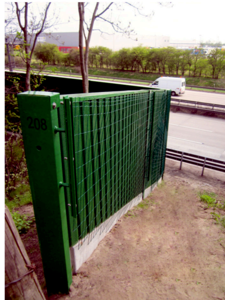
Fertige Lärmschutzwände mit Rankgittern in verschiedenen Ausführungen
